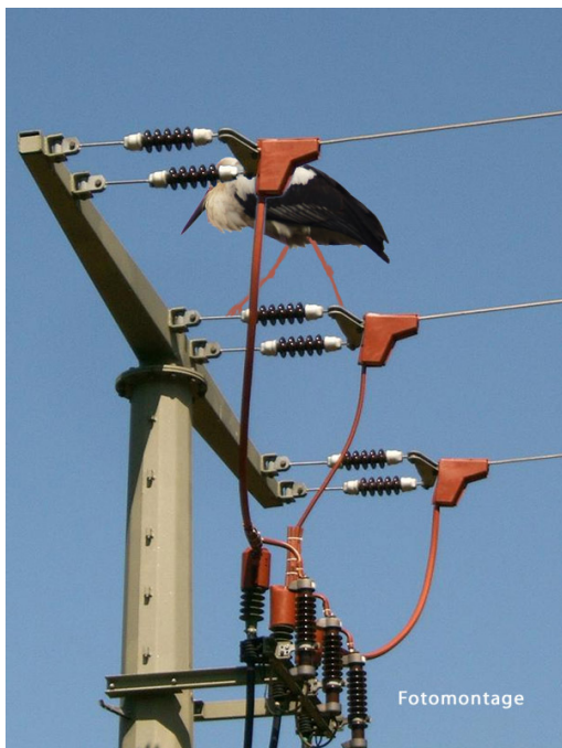
Abb. 6: Schritt überbrückt Maximal-Potential und 0-Potential = Stromschlag
